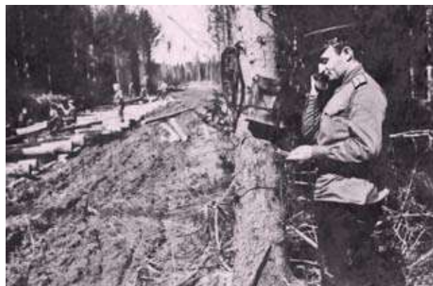
К-С. Х. Ужахов на строительстве железной дороги
